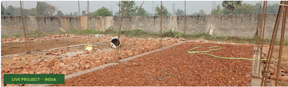
AGGREGATE BASE OVER PLINTH, BEFORE SLAB POUR
